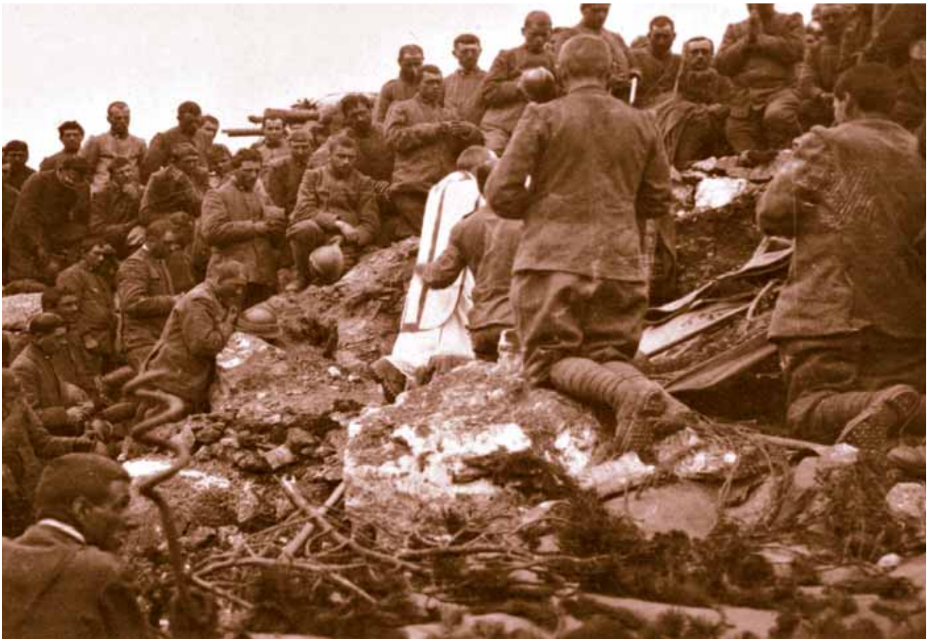
Messa al campo sull'Ortigara
